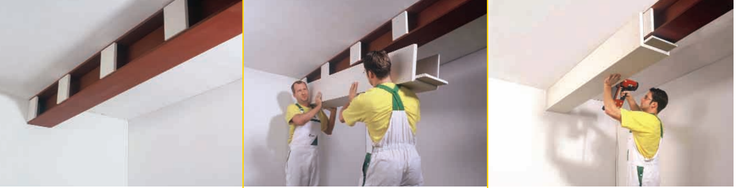
Trägerbekleidungen mit Knaggentechnik.
